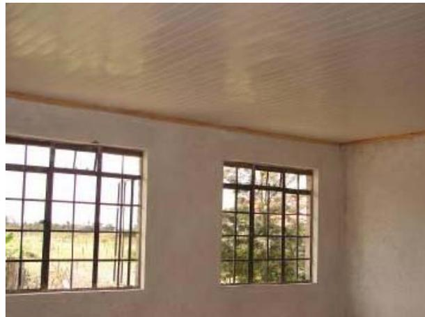
Nei soffitti delle aule è stato necessario infittire il traliccio di sostegno per ottenere un risultato accettabile con i fogli di UPVC.
