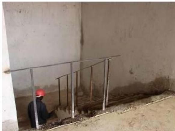
Anche al primo piano hanno ultimato il getto del terrazzo; manca la rifinitura. I parapetti del corridoio sono stati saldati e ancorati anche al soffitto; le ringhiere sulle scale sono fissate e saranno completate con un corrimano in legno.
