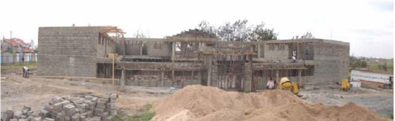
Anche il corridoio dell'ingresso è stato ultimato con la trave di completamento in sommità delle colonne.
