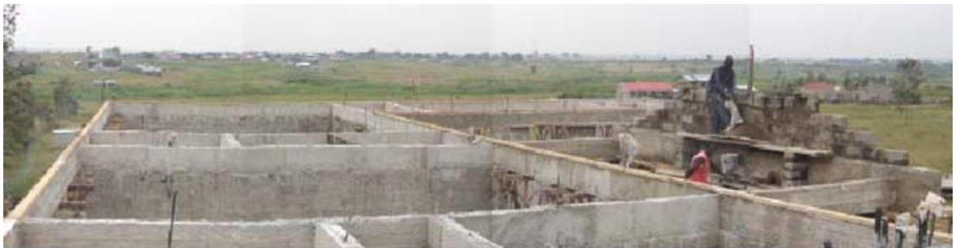
Sopra ai muri portanti e' stata gettata la trave di completamento per sostenere le travature del tetto.
